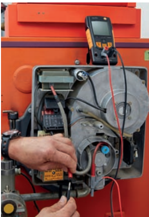
Подготовка к измерению ионизационного тока
