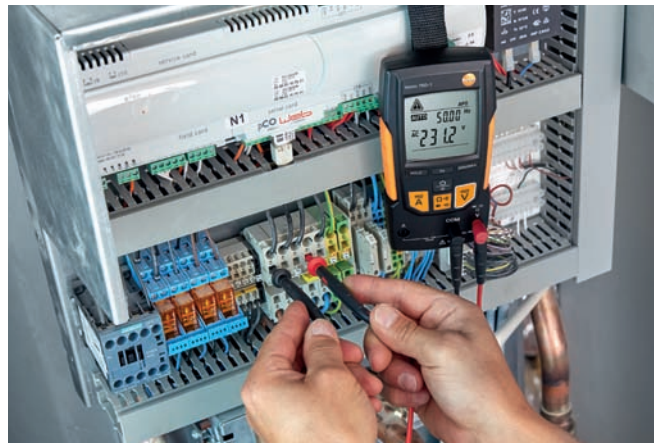
Проверка напряжения в щитке автоматики теплового насоса
