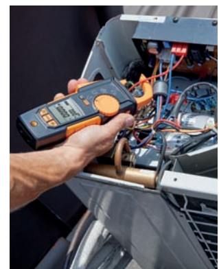
Подвешивание токоизмерительных клещей к наружному блоку холодильной установки
