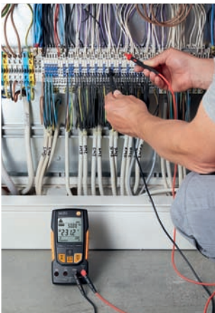
Проверка напряжения в распределительном щитке
